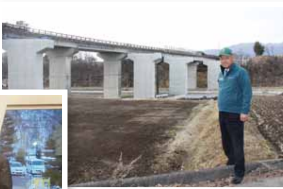
▲早期4車線化へ工事の進むR141平原大橋
