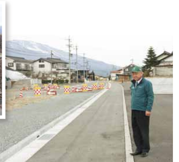
県道耳取三岡停車場線森山地区通路整備状況
