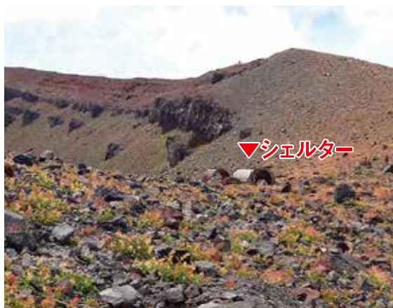
浅間山(前掛山)に設置されているシェルター
