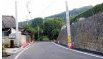
県道八幡小諸線拡幅 県道八幡小諸線、久保地区において、道幅が狭く危険な箇所があり、県の素早い対応により、電柱移転を終了。側溝整備等を進め、完成間近。
