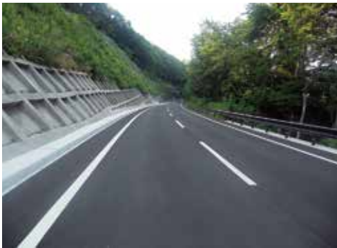
県道立科小諸線久保地区 平成25年度 造成拡幅改良工事完了
