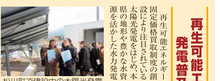
松川町で建設中の太陽光発電
