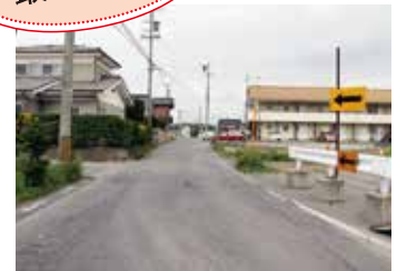
長年の懸案であった県道佐久小諸線、森山区長林の拡幅と歩道設置工事に着工。 (来年度完成予定)
