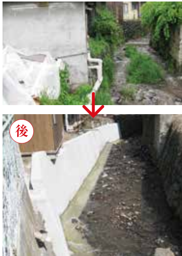
住民からの陳情を受けての河川修復。個々の暮らしから地域の安全対策へ…。
